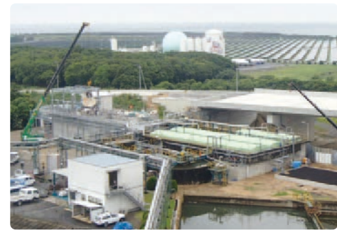
排水処理施設増強工事
